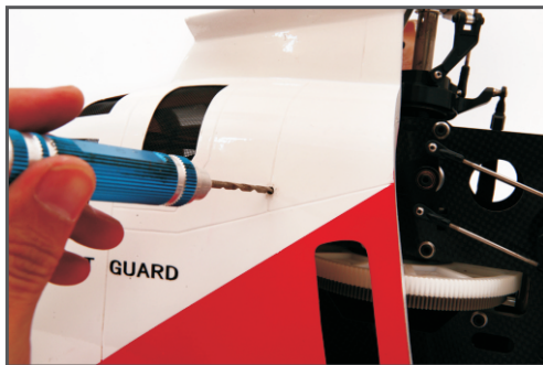
14. 目测找出合适的安装位置，打3mm孔（位置以不干涉里面机械工作就行）。
